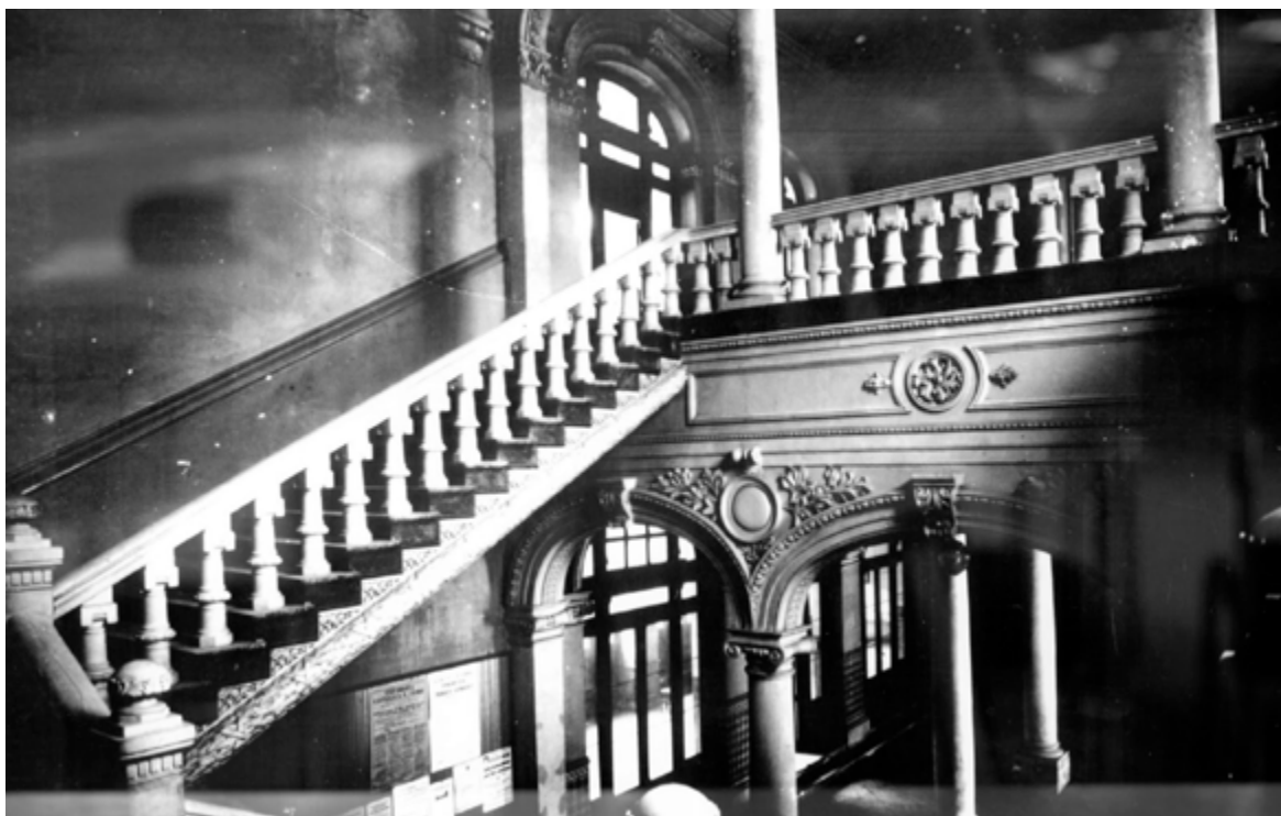
ESCALERA PRINCIPAL DE ACCESO A LA PLANTA SUPERIOR. UNIVERSIDAD DE ZARAGOZA.
