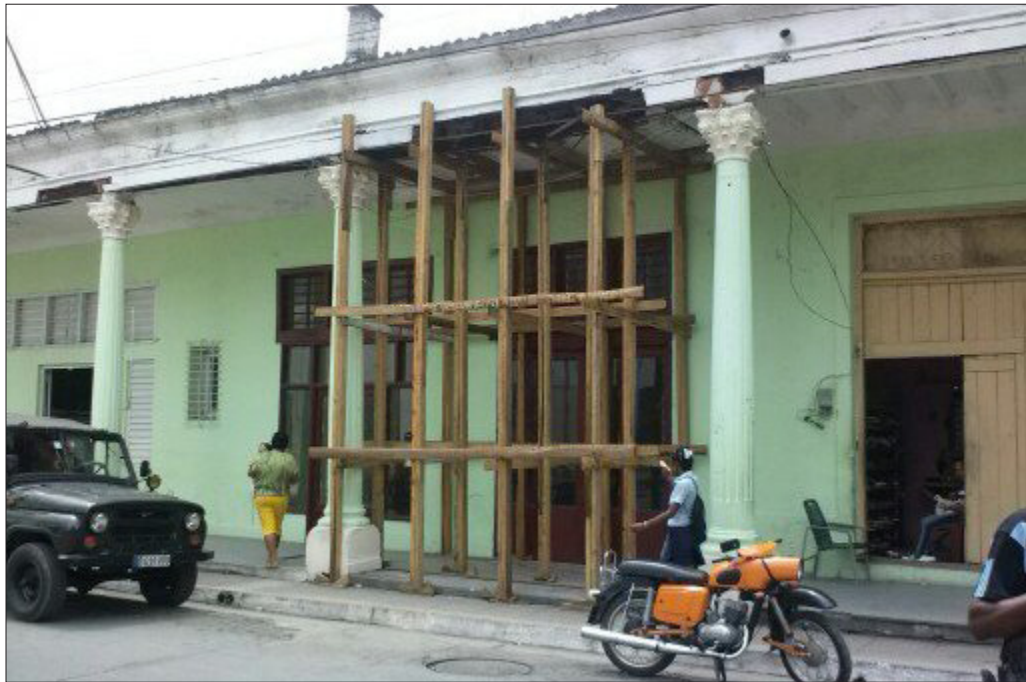
Edificación en peligro de derrumbe en la calle Vélez Caviedes de Pinar del Río, Cuba.
