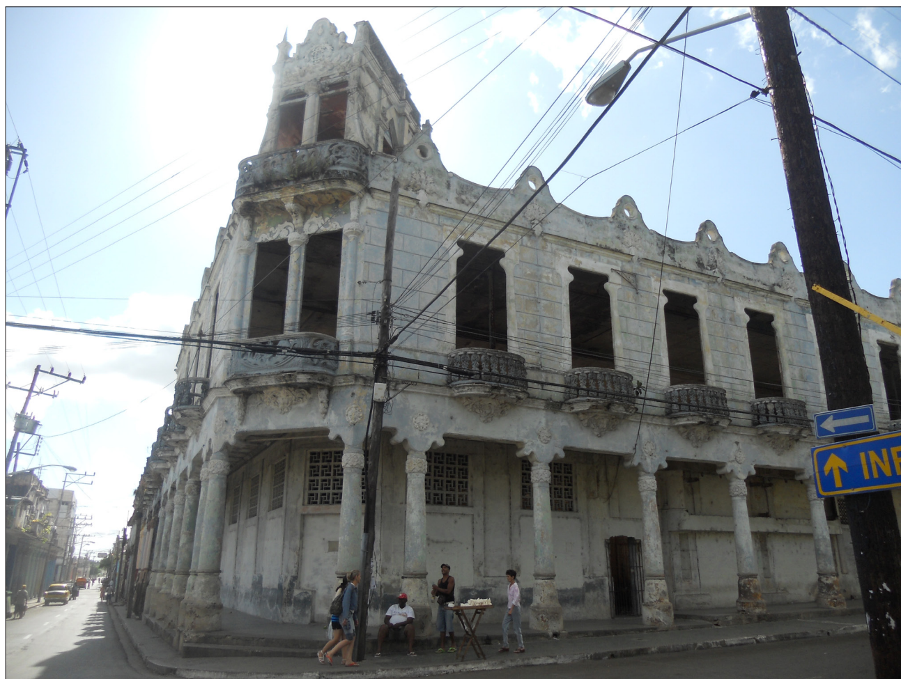
Vista actual del antiguo Hotel Comercio en el centro de la ciudad de Pinar del Río.
