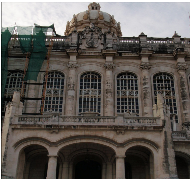
Palacio Presidencial en construcción. Foto: Jesuadín Pérez Valdés.
