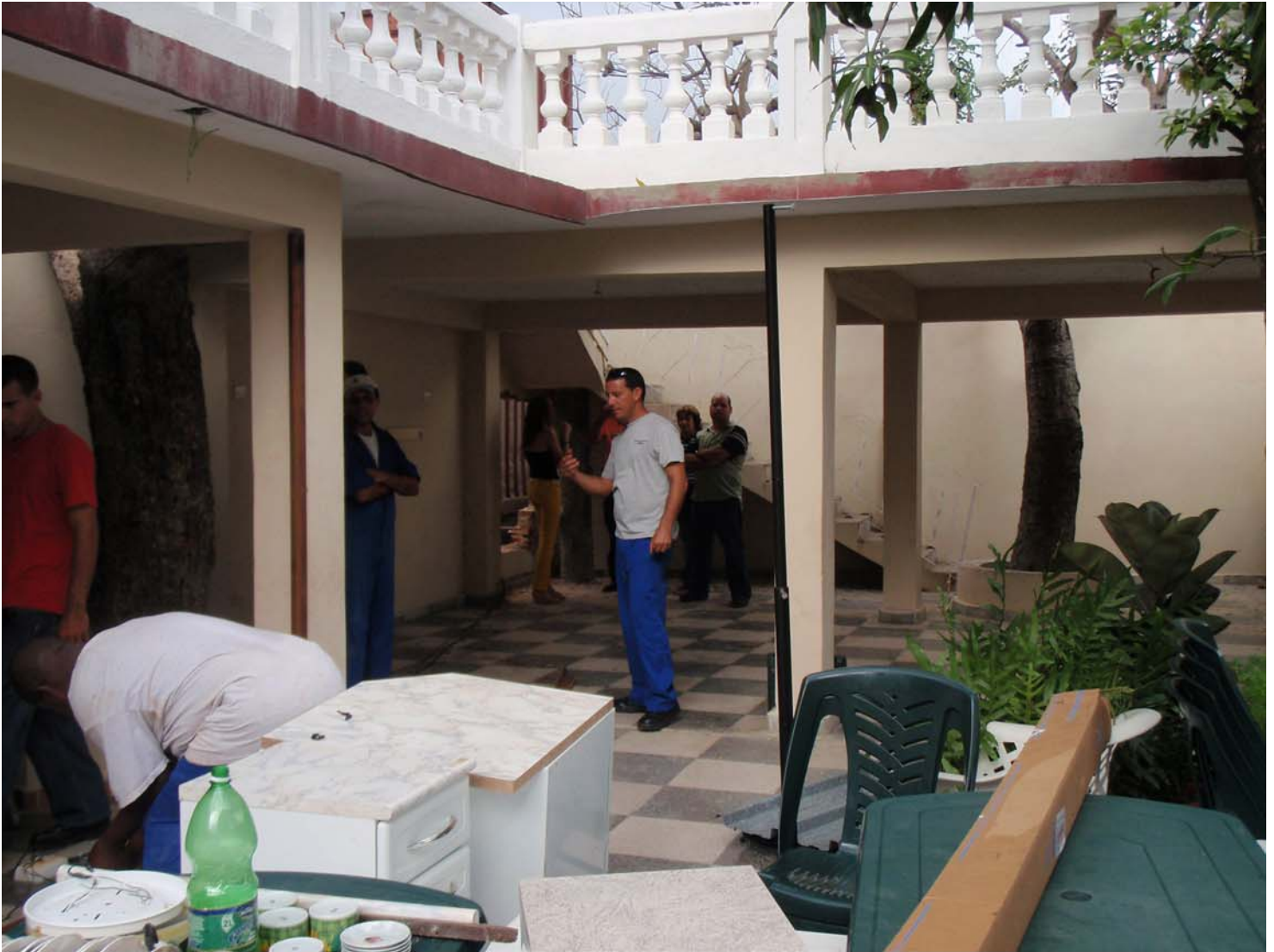
Como estaba el patio de la familia Gálvez Chiu en el momento de la intervención y el levantamiento del doble muro.
